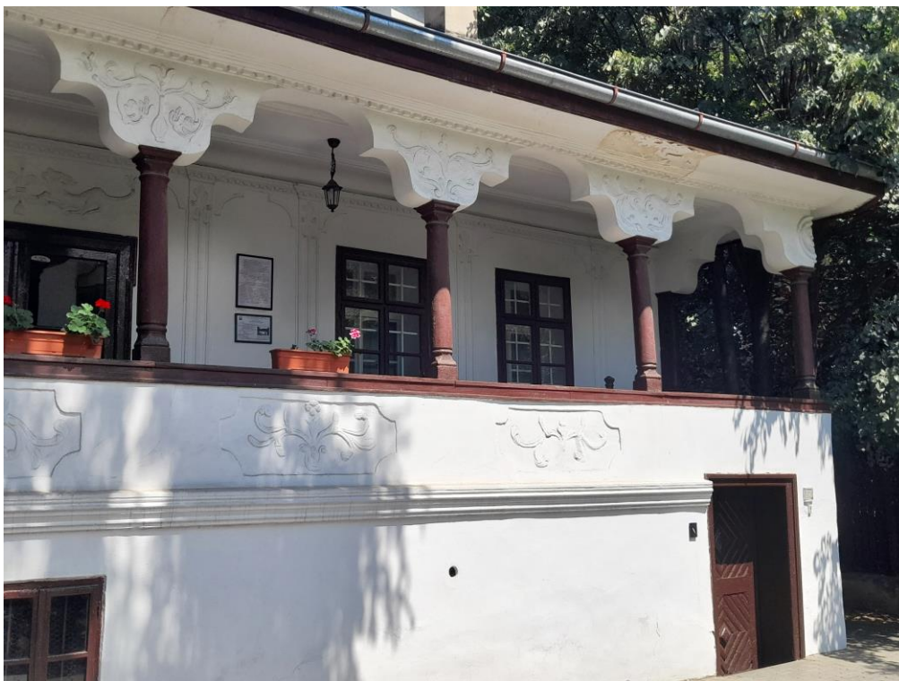
Fig. 3. Casa Dobrescu din Ploiești (Muzeul „I.L. Caragiale”), cca. 1800, tipologia tradițională dezvoltată, comună mediului rural și urban, cu două caturi (pivniță și locuință la etaj), scară prin pridvor, pălimar din zid.
